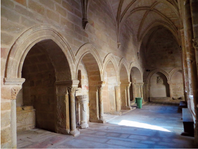
Vista de los arcosolios seriados de una de las pandas del claustro de la catedral de Plasencia
