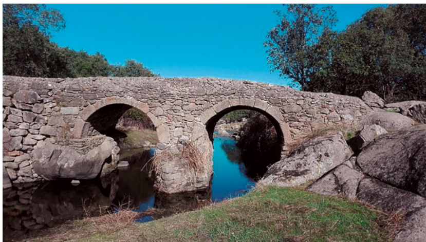
Puente del Capellán. Aguas arriba de la Presa de Casilla. Foto de José Antonio Pérez Rubio
